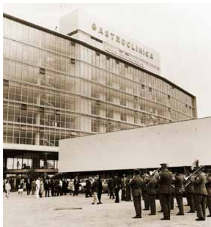
Solenidade de inauguração da Gastroclínica, atual Hospital Professor Edmundo Vasconcelos Official inauguration of the Gastroclínica Hospital, now the Professor Edmundo Vasconcelos Hospital
